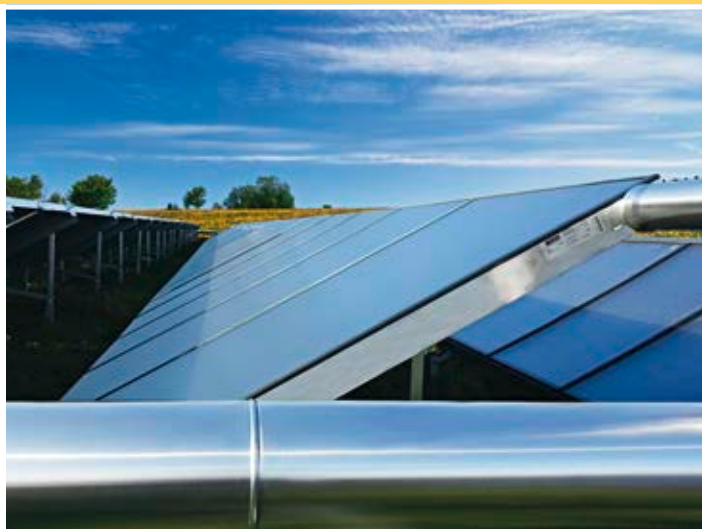
Abb. 18 Flachkollektoren sind für Prozesswärme am häufigsten verbreitet. Quelle: KBB Kollektorbau
