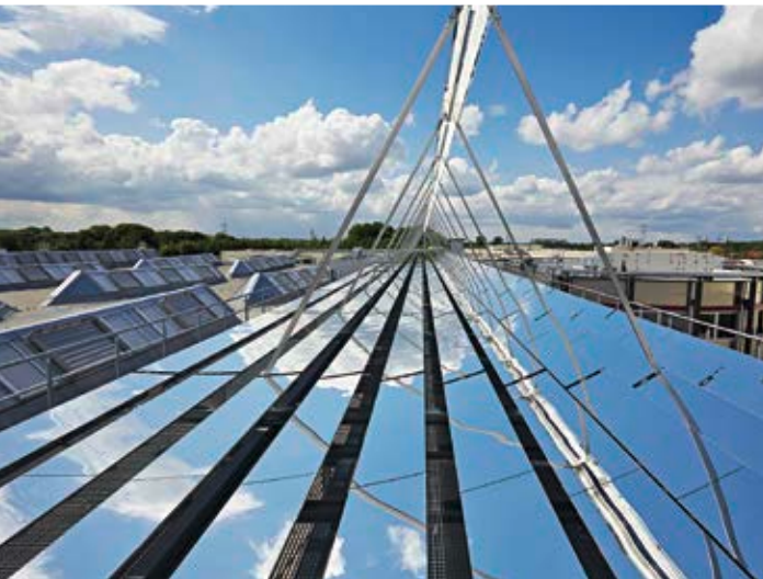
Abb. 20 Fresnel-Reflektoren: Spiegellamellen werden der Sonne nachgeführt. Quelle: Industrial Solar GmbH
