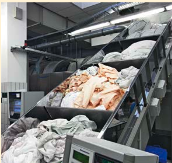
Abb. 15 Auf dem abgebildeten Beladeband wird die Schmutzwäsche in die Waschstraße geführt. Das dort verwendete Waschwasser kann solar vorgewärmt werden. Quelle: Fraunhofer ISE, Stefan Hess
