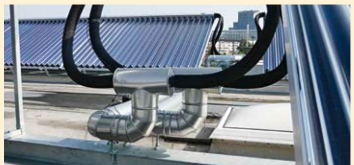
Abb. 10 Oben: Waschmittelrückstände und Schaum werden mit destilliertem Wasser abgespült. Anschließend wird das Auto mit Heißluft aus bis zu elf Luftkanälen getrocknet. Unten: Vakuumröhrenkollektoren auf dem Dach der Autowaschanlage in Mannheim. Quelle: Mr Wash
